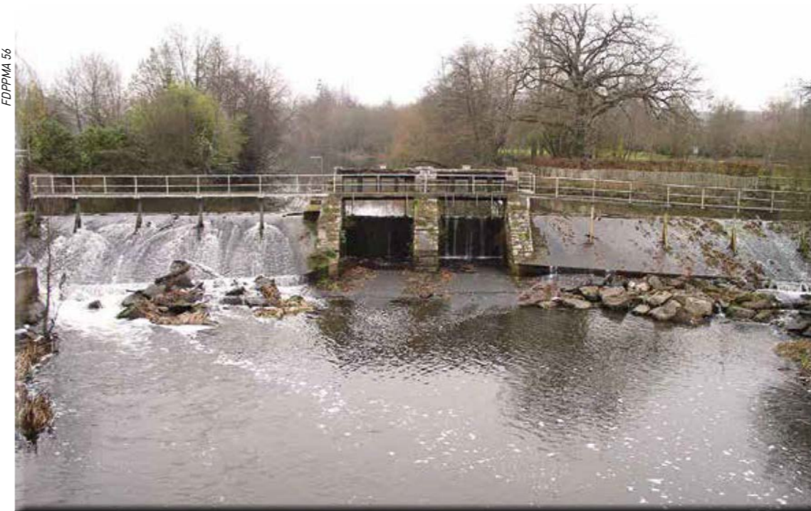
Faute d'aménagement, le barrage de la Gacilly bloque encore l'entrée de l'Aff dont tous les autres obstacles ont été levés.
