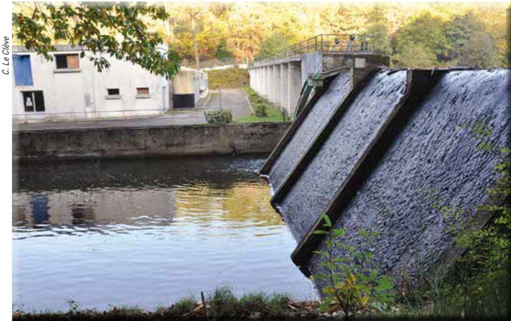
Malgré une passe, le barrage de Pont Sal est un point de blocage important pour les anguilles. Pour les autres migrateurs, c'est un obstacle total.
